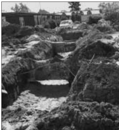
Takto to vypadalo v areálu ZŠ Kostelní – Kamenka, kde probíhá rekonstrukce plynové kotelny, dne 29. srpna 2005. Z důvodů stavebních prací začal školní rok na této ZŠ až 5. září 2005. Foto: PhDr. Mirko Nosek
